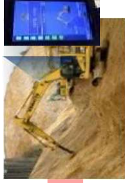
ICT土工工事 (主)浜田八重町前線後野工区
